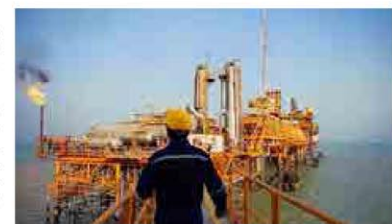
اطلس زمین شناسی نفت خلیج فارس در حوضه روسوی با وسعت ۱۱۱ هزار کیلومتر مربع با همکاری محققان پژوهشگاه علوم زمین پردیس بالادستی پژوهشگاه صنعت نفت تهیه می شود.
